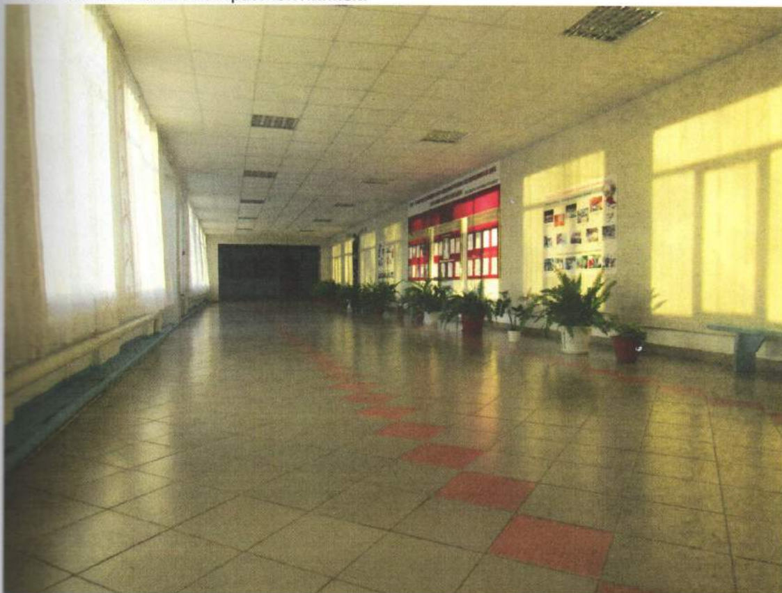
5. Перед лестницами, дверьми установлены контрастные тактильные плитки.
