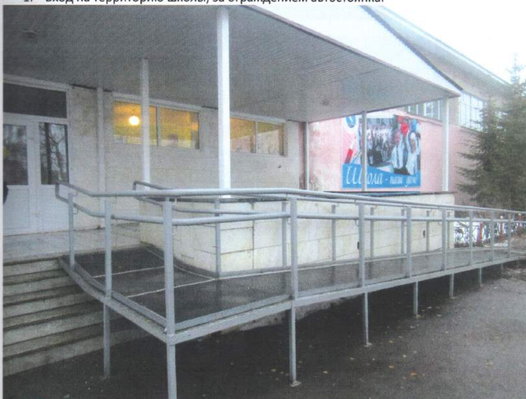
2. Пандус с нескользящим покрытием.
