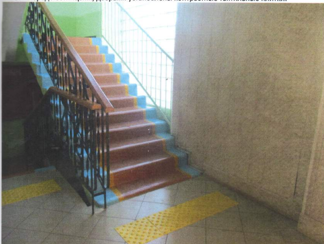
5. Перед лестницами, дверьми установлены контрастные тактильные плитки.
